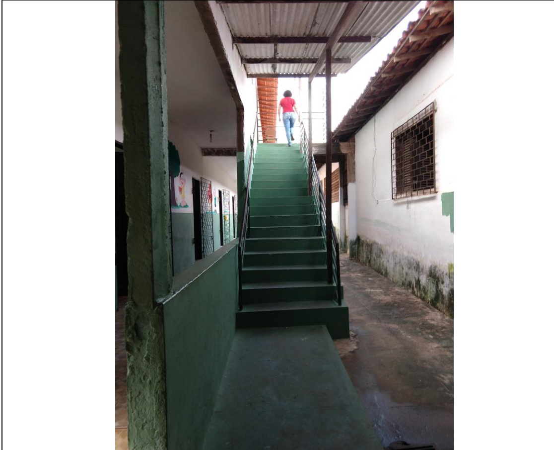
Foto 09 – Escada de acesso ao pavimento superior
