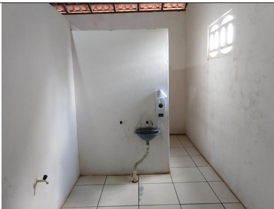
Foto 08 – Banheiro pav. superior
