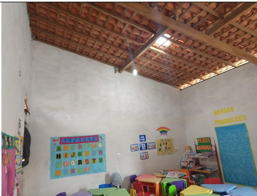
Foto 04 – Sala de aula
