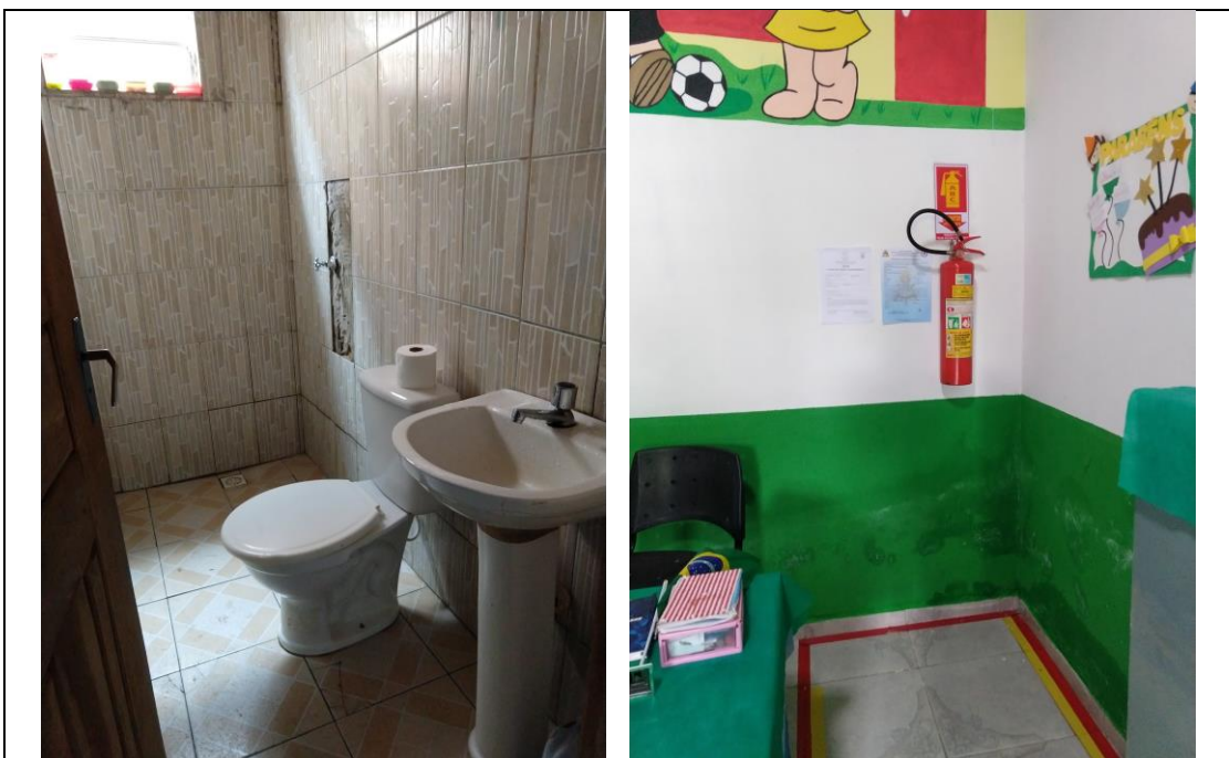
Foto 08 – Banheiro e secretaria
